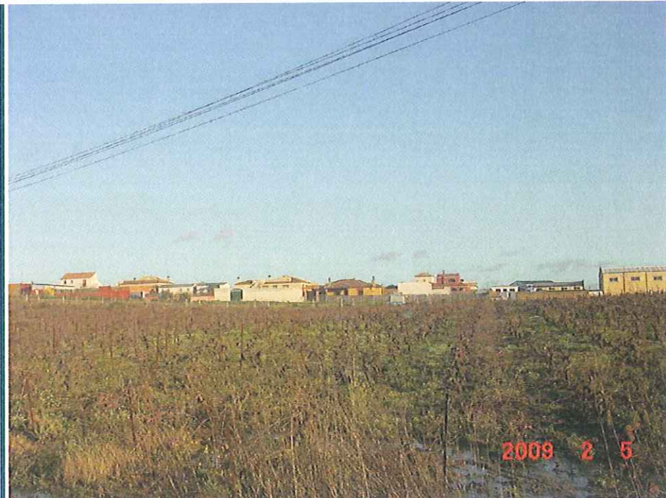
4. Grupo de edificaciones al Sur de la zona
